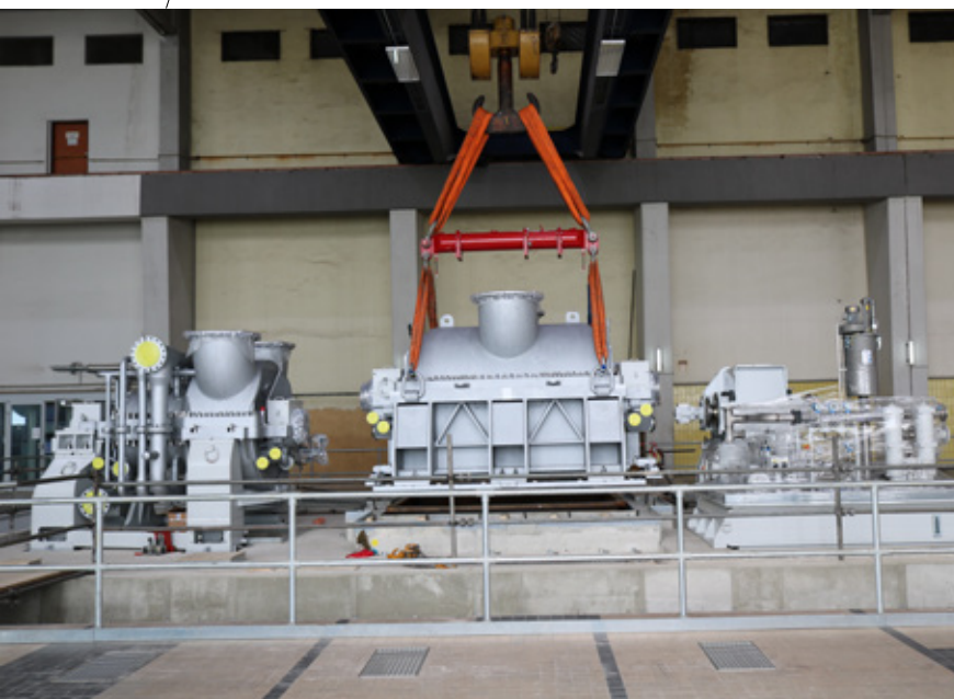
/ Positionieren der Niederdruck-Turbine zwischen Hochdruck-Turbine und Getriebe
