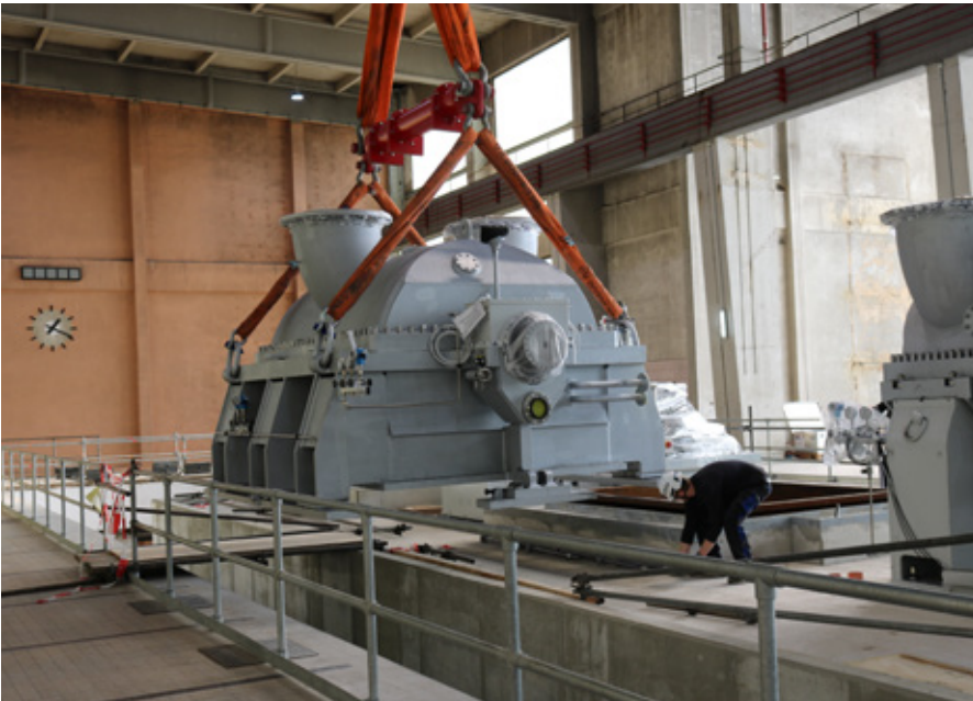
/ Einbringen der Niederdruck-Turbine
