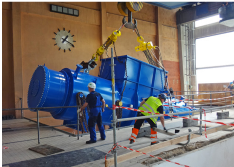
/ Einheben des Hauptkondensators real
