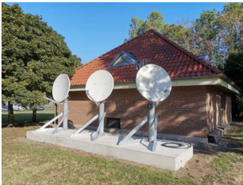
Die aus drei Parabolantennen bestehende Kopfstation ermöglicht den Empfang von deutschsprachigen und internationalen Sendern.
