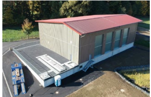
Mit dem Wasserwerk Nieste versorgt die NSG die Stadt Kassel mit Trinkwasser aus einem sogenannten artesischen Trinkbrunnen.
