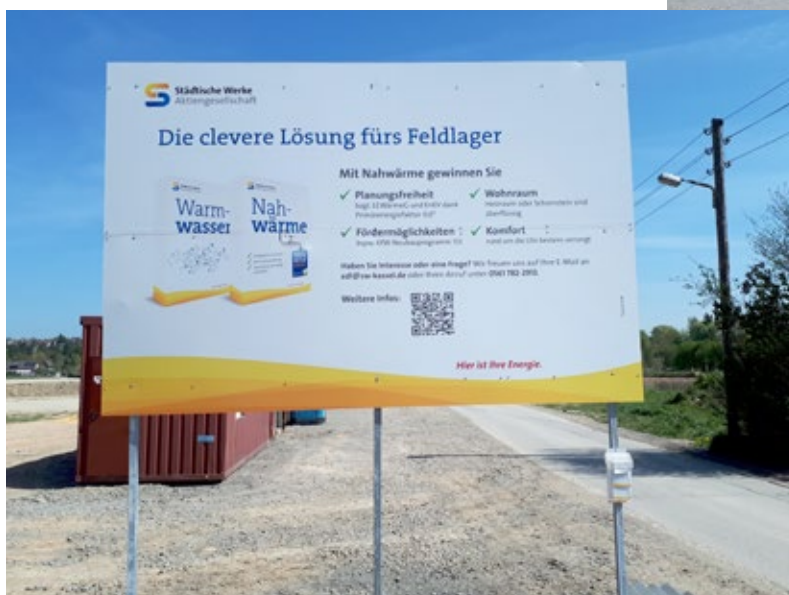
Die Städtischen Werke werden das Neubaugebiet energieeffizient mit Nahwärme versorgen. Ein Schild am Beginn des Baufeldes informiert künftige Bewohner.
