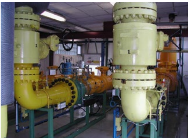
/ Gasdruckregelanlage (GDR)
