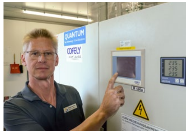
Zentrale Steuereinheit der Kälteversorgung. Ralf-Guido Spangenberg vor Ort kann regelnd eingreifen.
